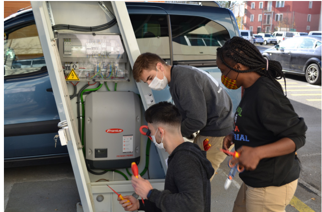
• Primeras prácticas del alumnado, comprobación de tensiones y carga en el inversor.
