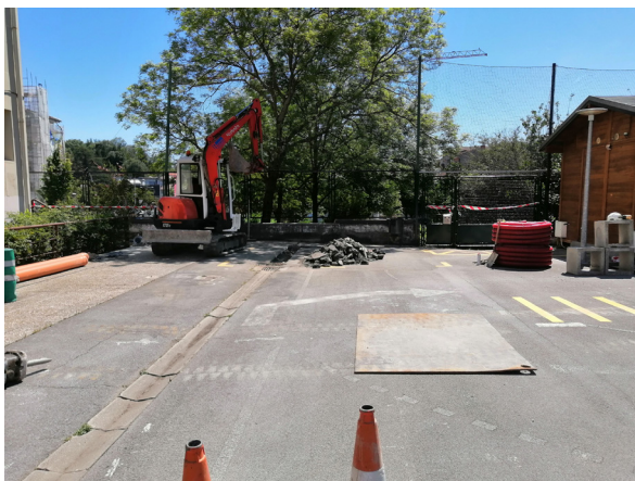
• Inicio de la obra e instalaciones.
