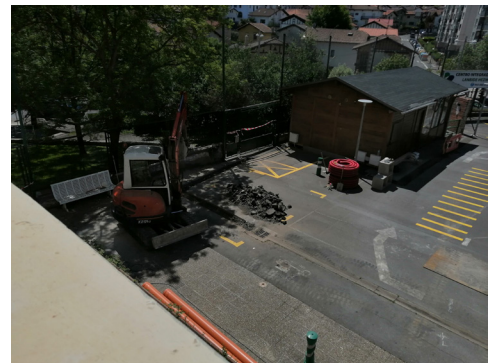
● Inicio de la obra. Excavación de la zanja.
