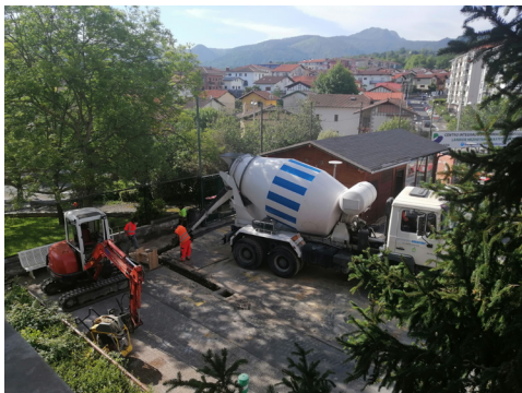
● Hormigonado de las zanjas y arquetas de registro.
