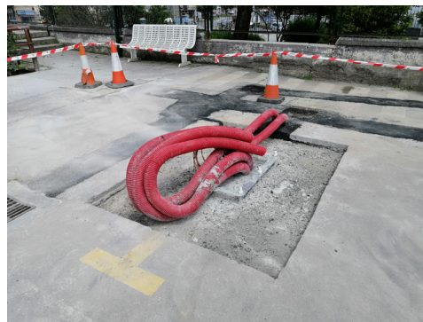
Finalización de la obra civil.
