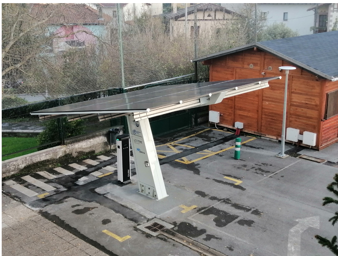
• Obra e instalaciones totalmente finalizadas y en servicio.
